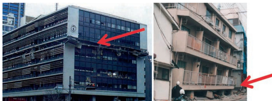
Prăbușirea unui nivel superior intermediar al clădirii Primăriei din Kobe, Japonia, la cutremurul din 1995, din cauza întreruperii armăturilor unor elemente verticale de rezistență (partea stângă). Același tip de cedare, la un bloc de locuințe (partea dreaptă).
