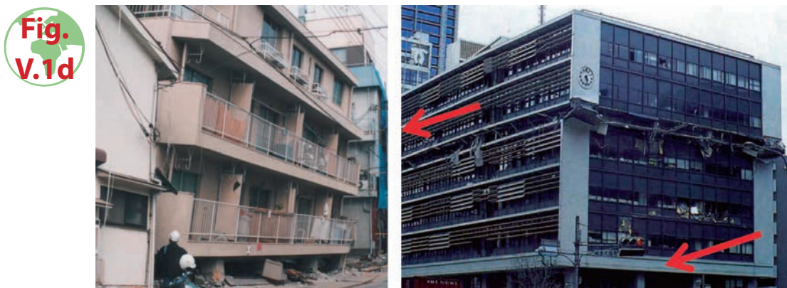
Dreapta: prăbușirea unui nivel superior intermediar al clădirii Primăriei din Kobe, la cutremurul Kobe, Japonia, din 1995, din cauza întreruperii armăturilor unor elemente verticale de rezistență. Stânga: același tip de cedare ca acela prezentat mai sus, la un bloc de locuințe.
