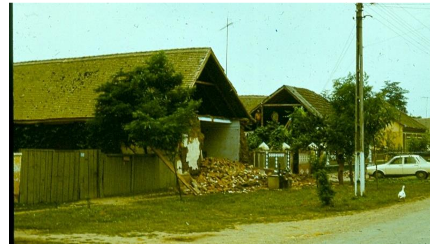
Fig. 7. Banloc 1991, căderea calcanelor rurale la clădirile din pământ
