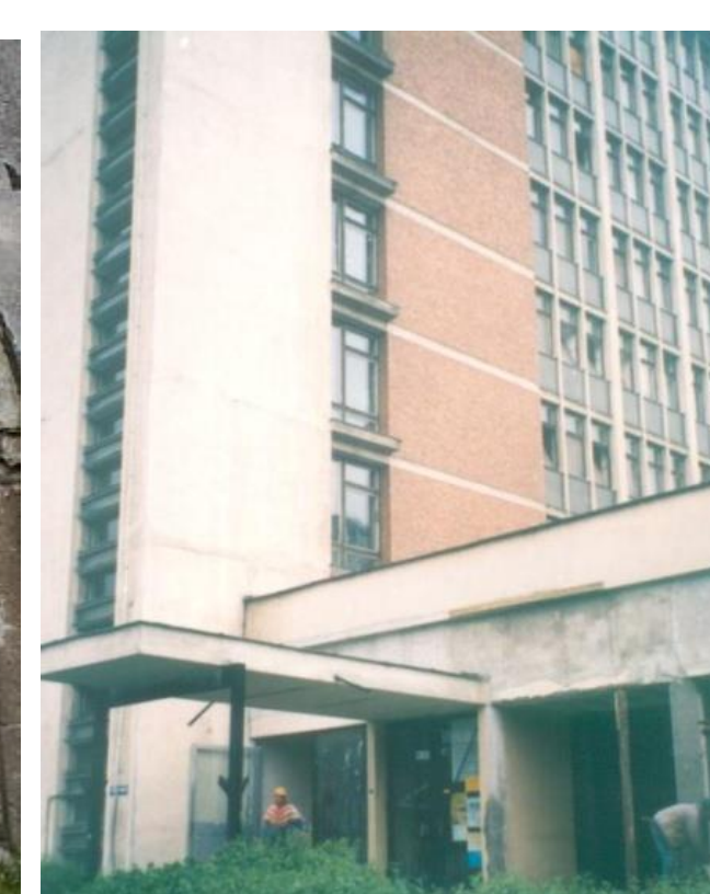
Fig. 10. Clădire P+8 instrumentată seismic
