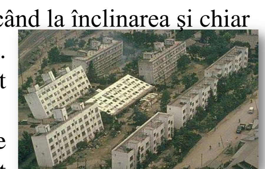
Fig.5. Cutremurul din Japonia 1964 Sursa: http://en.wikipedia.org/wiki/1964_Niigata_earthquake
