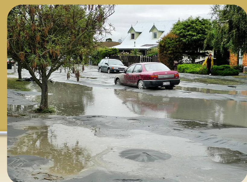
Sursa: http://commons.wikimedia.org/wiki/File:Sink_holes_and_liquefaction_on_roads_-_Avonside_in_Christchurch.jpg
