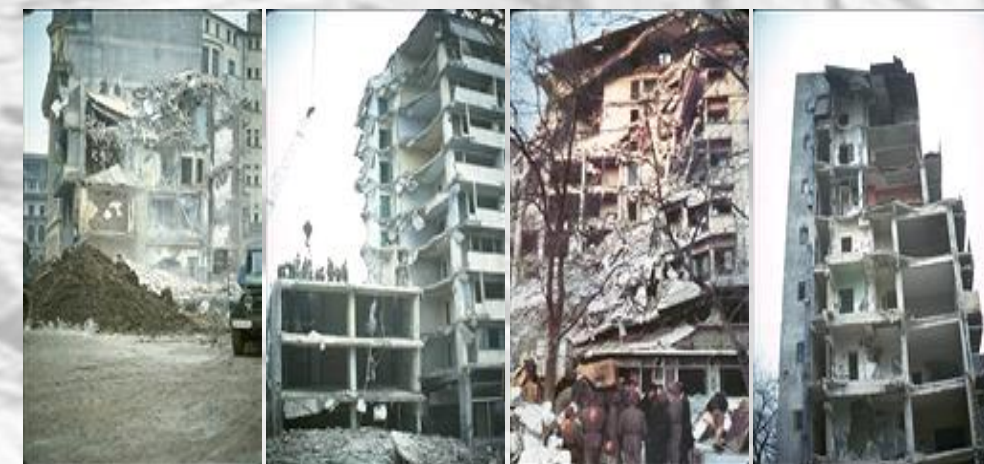
Clădire cu schelet de beton armat (P+10...12E) și (P+110E)- Str. Colonadelor (Str. I. Ghica nr.8) și str. Bibliotecii nr. 6 București (Continental); Clădire cu diafragme de beton armat și parter flexibil (P+8E)- Sos. Stefan cel Mare nr. 33 București (colț cu Lizeanu); Zidărie cu schelet din beton armat (P+8E)- Bd. Bălcescu nr. 3 - 5 București (Dunărea); Clădire cu schelet de beton armat (P+8E)- Str. Apolodor nr. 31
