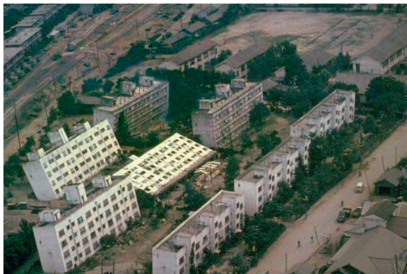
Daune provocate de lichefierea terenului în urma cutremurului din 1964, produs la Niigata, Japonia
