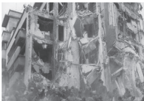
Clădiri de locuit avariate – cu fisuri, crăpături/cu prăbușire parțială sau totală
