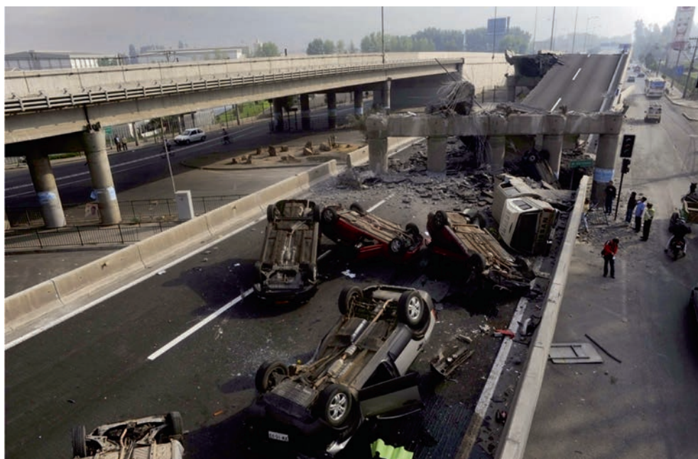
Poduri/autostrăzi, prăbușire parțială sau totală
