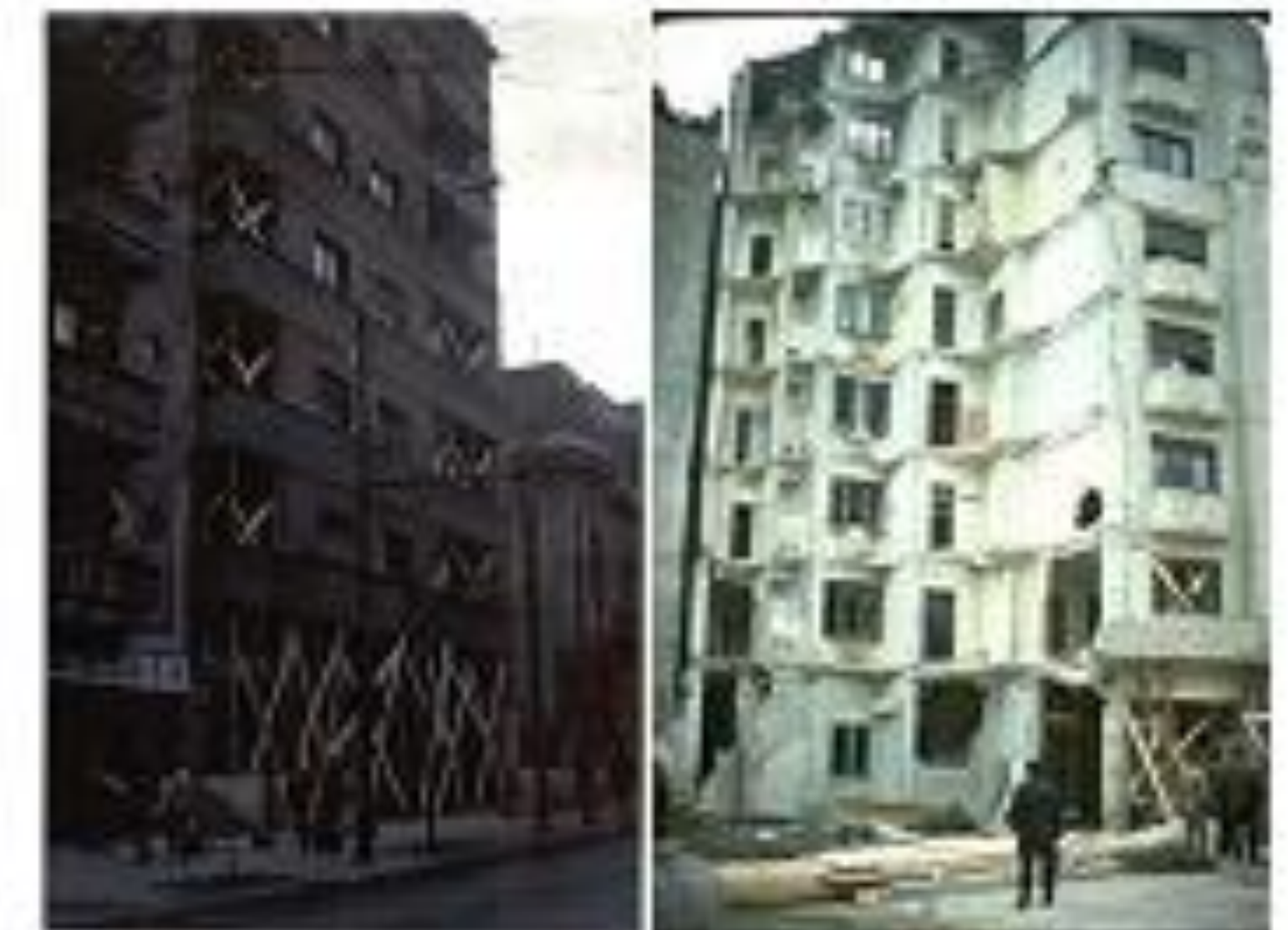
Fig. 3. Zădărie și schelet din beton armat (P+7E)- Bd. Kogălniceanu nr. 7 - 9. Fig. 4. Clădire cu schelet de beton armat (P+7E)-Bd. Magheru nr. 5 (Franklin nr. 11)
