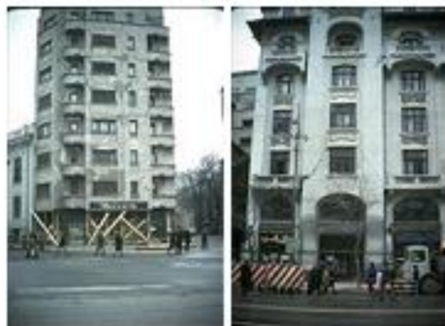
Fig. 1. Zădărie cu schelet din beton armat (P+7E)-Bd. Magheru nr. 24. Fig. 2. Structură din zidărie (P+5E)-Bd. Bălcescu nr. 26;
