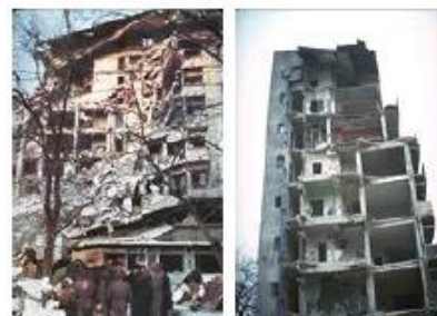
Fig. 7. Zidărie cu schelet din beton armat (P-8E)- Bd. Bălcescu nr. 3-5 (Dunărea)
