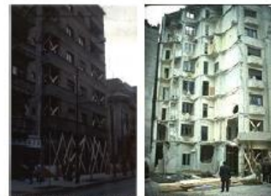
Fig. 3. Zidărie și schelet din beton armat (P-7E)- Bd. Kogălniceanu nr. 7-9
