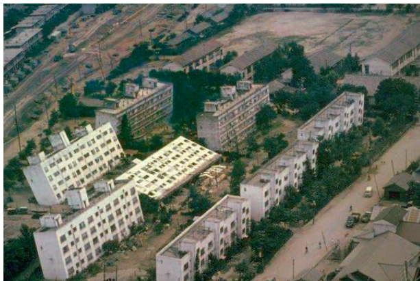
Lichefierea solului și efectul acesteia (bascularea clădirilor) urmare a seismului produs la Niigata (Japonia), 1964 (sursa: http://earthquake.usgs.gov )
