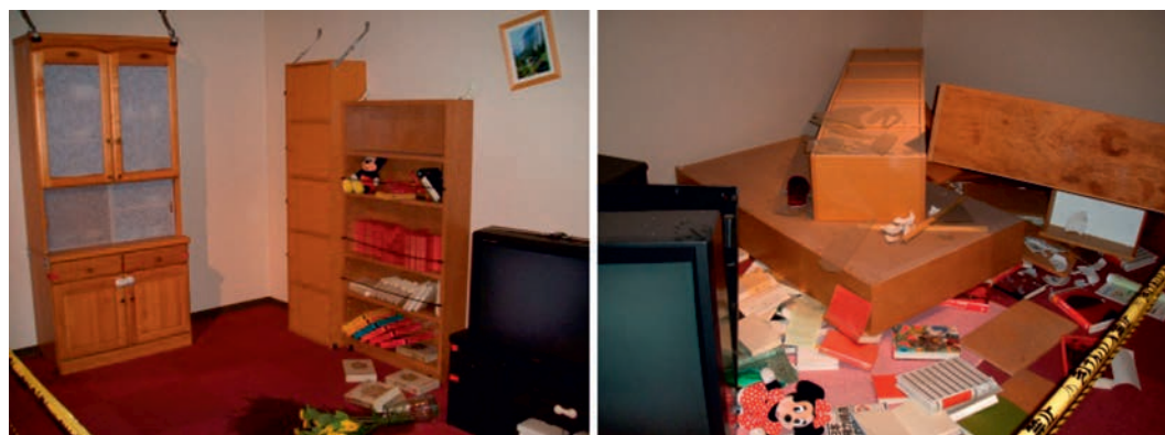
Efectul lipsei fixării mobilerului
