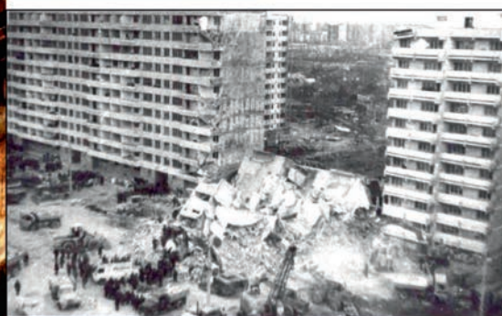
Clădirea Wilson, pre-1940, București (4 martie 1977)
