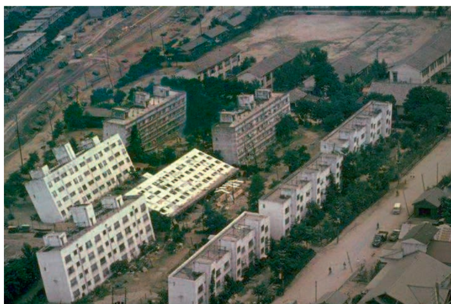
Daune provocate de lichefierea terenului în urma cutremurului din 1964, produs la Niigata, Japonia (sursa: http://www.ce.washington.edu/~liquefaction/selectpiclique/nigata64/tiltedbuilding.jpg )
