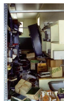
Fișete și rafturi prăbușite, după cutremurul Northridge, California, SUA, 1994
