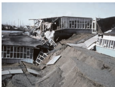
Alunecări de teren lângă o școală, induse de cutremurul Anchorage, Alaska, 1964
