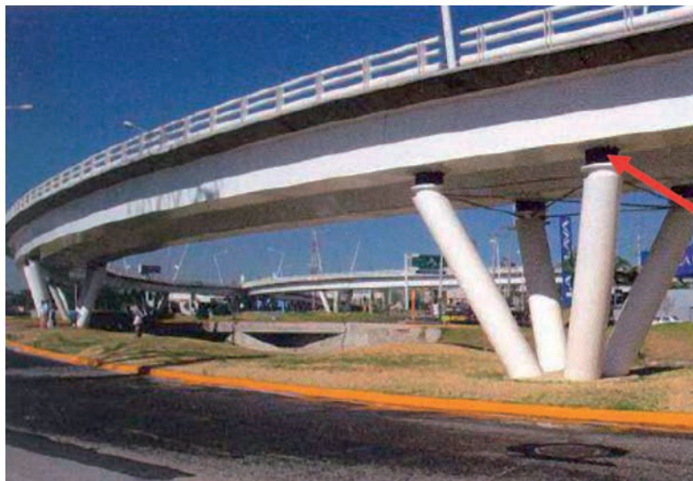
Pod izolat seismic în Mexic, Patria Acueducto
