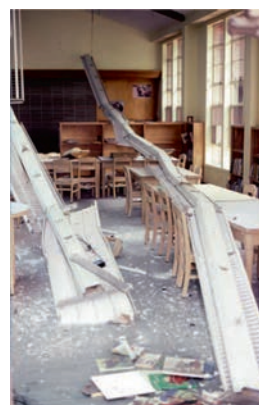
Căderea unor corpuri de iluminat, lămpi etc. în interiorul școlii, într-o clasă și în bibliotecă, după cutremurul Coalinga, California, 1983
