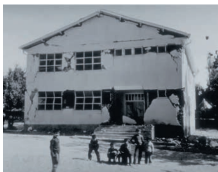
Exteriorul unei școli cu structură vulnerabilă, după cutremurul Lice, Turcia, 1975
