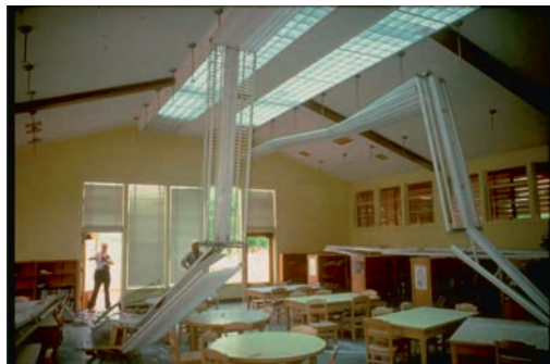
Căderea unor corpuri de iluminat, lămpi etc. în interiorul școlii, într-o clasă și în bibliotecă, după cutremurul Coalinga, California, 1983
