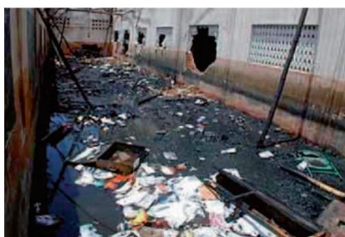
Clădirea unei școli după incendiul izbucnit ca urmare a unui cutremur (2004, India)
